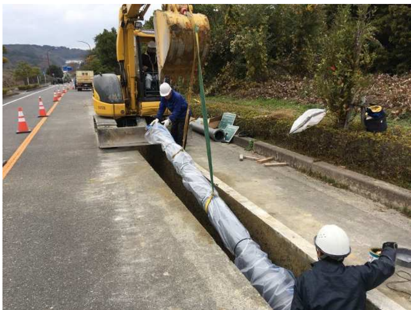
< 管路の更新工事 >
