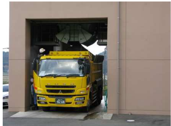
<汚泥搬出状況>
