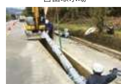
水道管の取り替え工事
