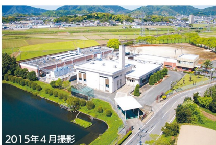
現在は解体作業が進められているし尿処理場（宗像市 曲）
