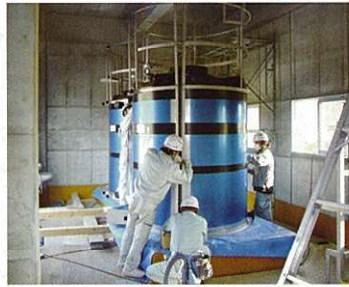
▲建設中の希硫酸注入設備
